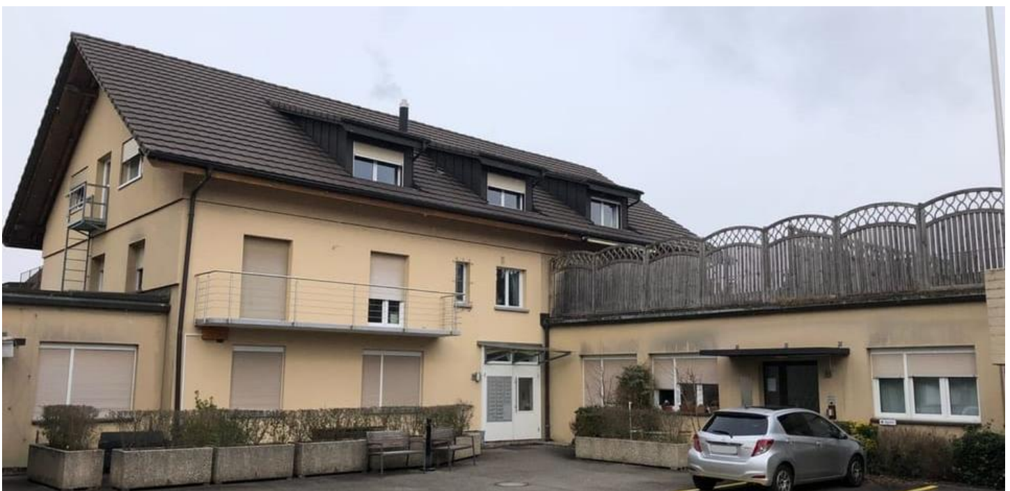
Die betroffenen Mieterinnen und Mieter wohnen in drei Gebäuden an der Mülliger- und Zelglistrasse in Windisch
